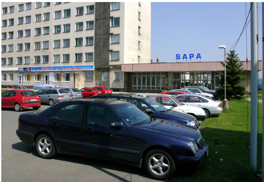
Obr. 1: Vstupní hala a hlavní administrativní budova velkoobchodní společnosti Sapa – Libušská 319, Praha – Libuš (Foto: Karla Štěpánková)
